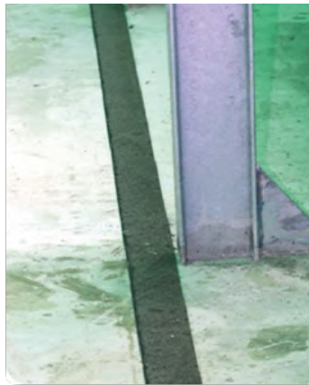
Figure 8 – Plaatsen van de verharde stroken
