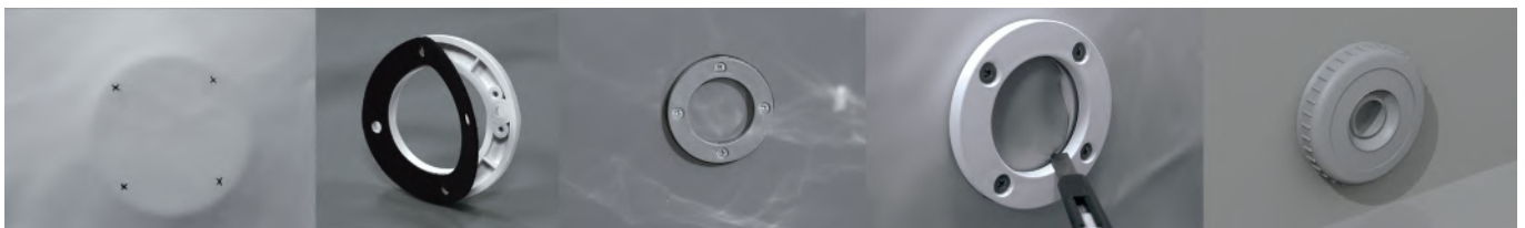
Figure 35 – Montage van de flens op de inspuiter
