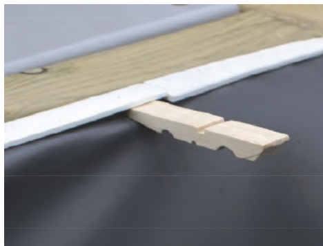
Figure 32 – De liner vastzetten met wasknijpers
